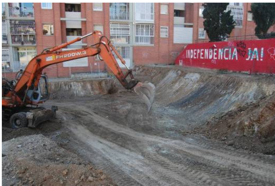
Fotografia núm. 25: treballs a la plataforma inferior
