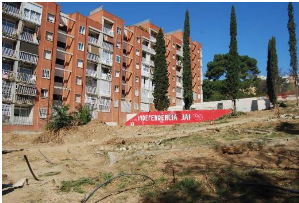
Fotografia núm. 1: estat dels jardins a l'inici de la intervenció
