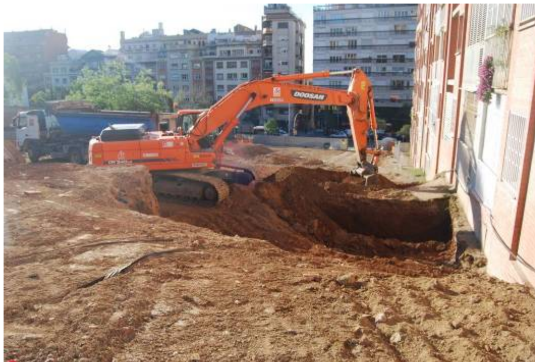
Fotografia núm. 27: treballs a la plataforma intermèdia
