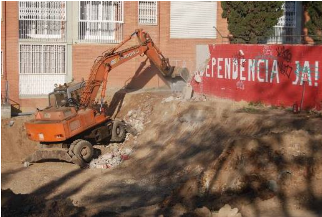
Fotografia núm. 19: desmuntatge dels murs de contenció
