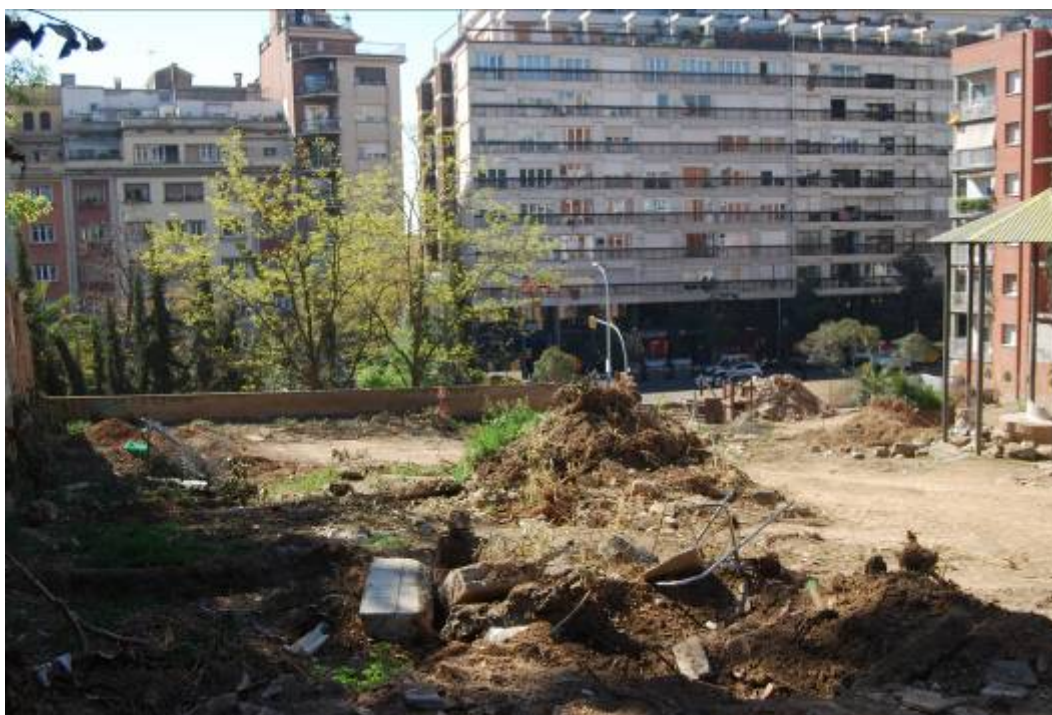
Fotografia núm. 2: estat dels jardins a l'inici de la intervenció
