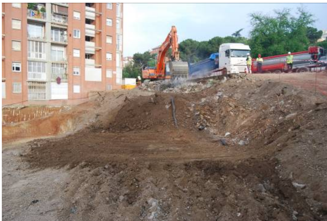
Fotografia núm. 33: treballs a la plataforma superior
