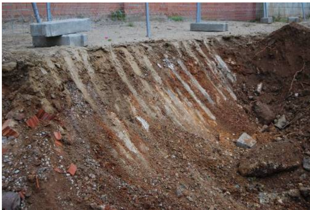
Fotografia núm. 23: aparició del substrat geològic a la plataforma inferior
