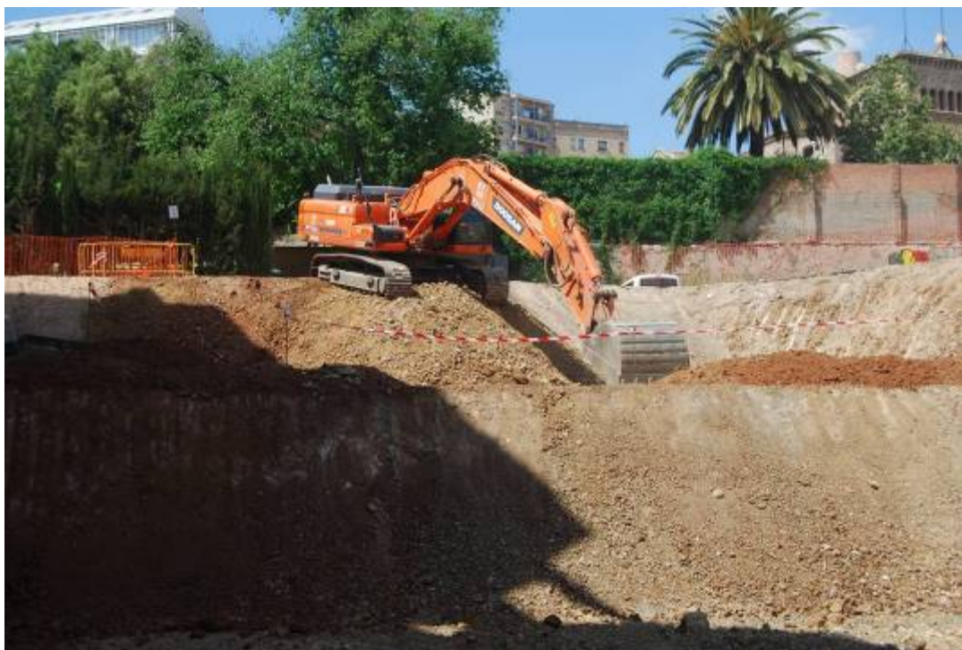
Fotografia núm. 51: treballs a la plataforma superior
