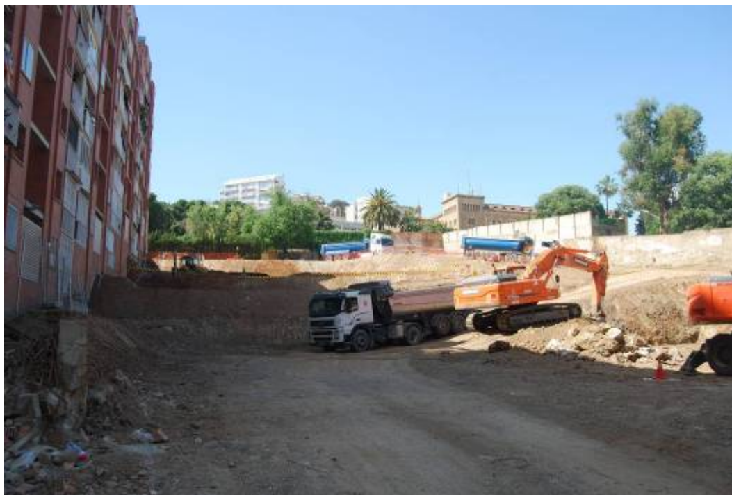
Fotografia núm. 53: vista de la obra amb les tres plataformes ja fetes
