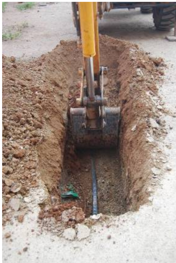
Fotografia núm. 9: obertura de la rasa 300
