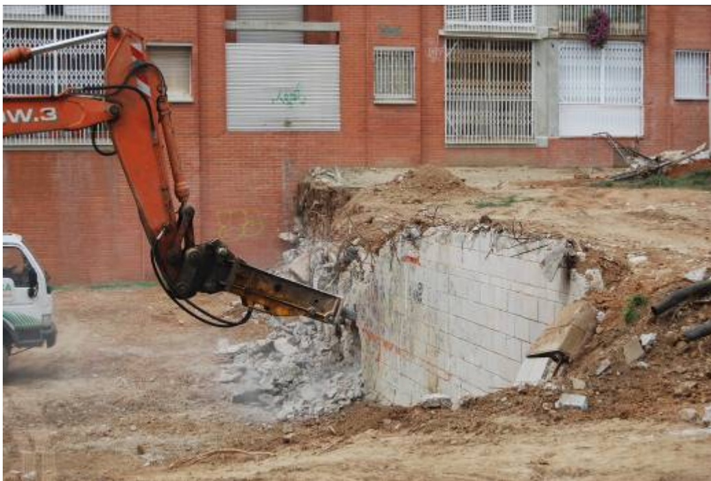
Fotografia núm. 18: desmuntatge dels murs de contenció
