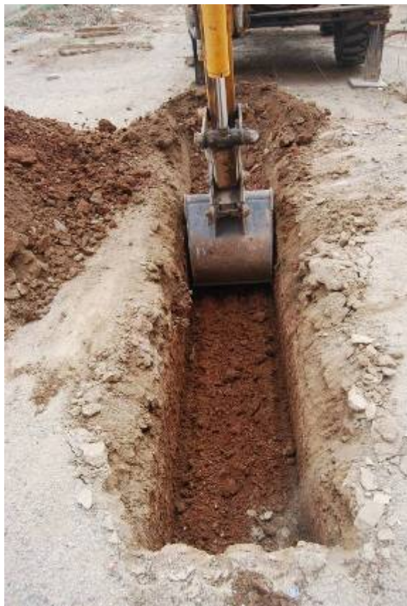
Fotografia núm. 3: obertura de la rasa 100
