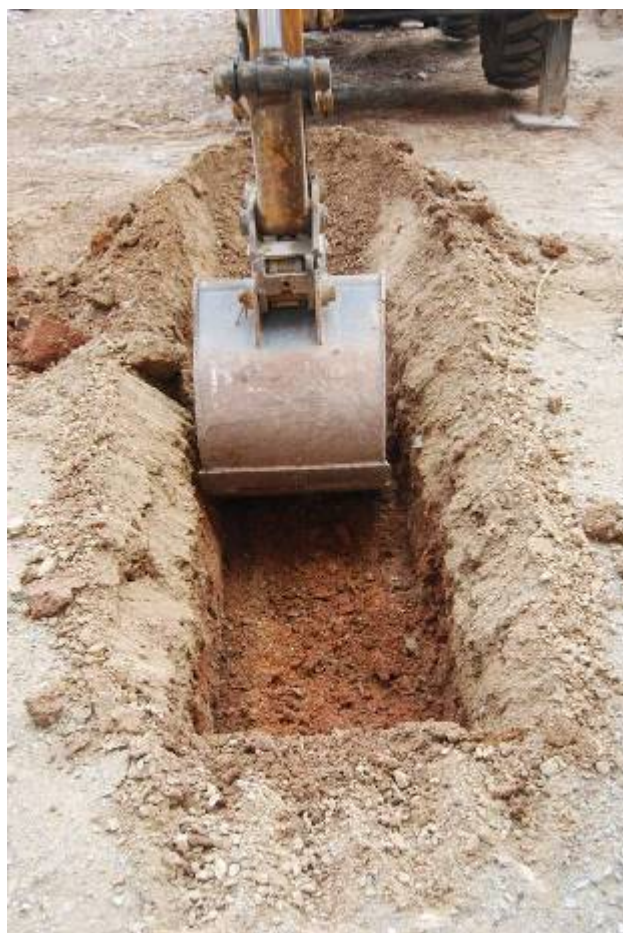
Fotografia núm. 6: obertura de la rasa 200
