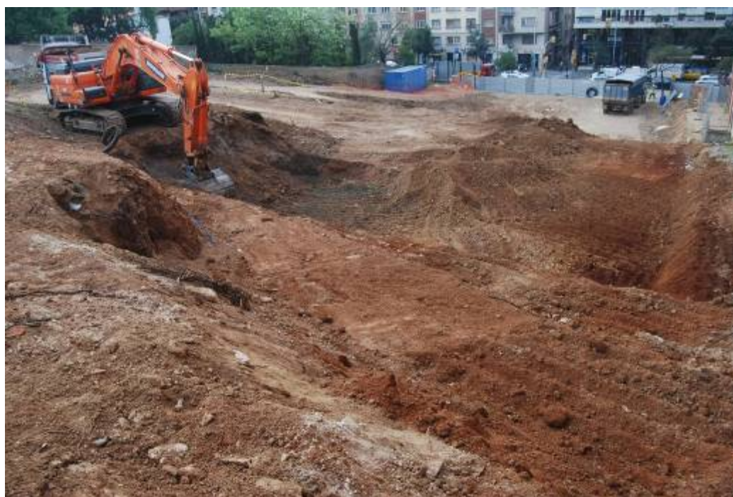
Fotografia núm. 28: treballs a la plataforma intermèdia
