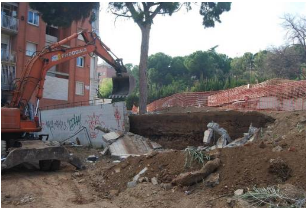
Fotografia núm. 20: desmuntatge dels murs de contenció
