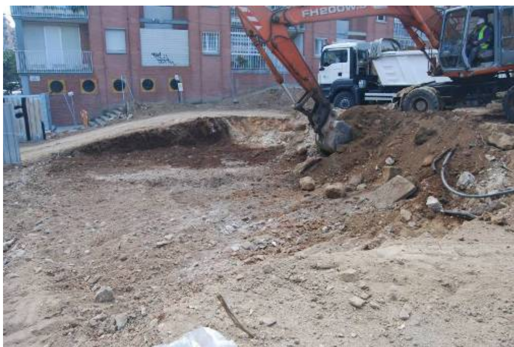
Fotografia núm. 24: treballs de rebaix a la plataforma inferior
