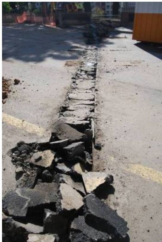
Fotografia núm. 15: obertura de la rasa 500
