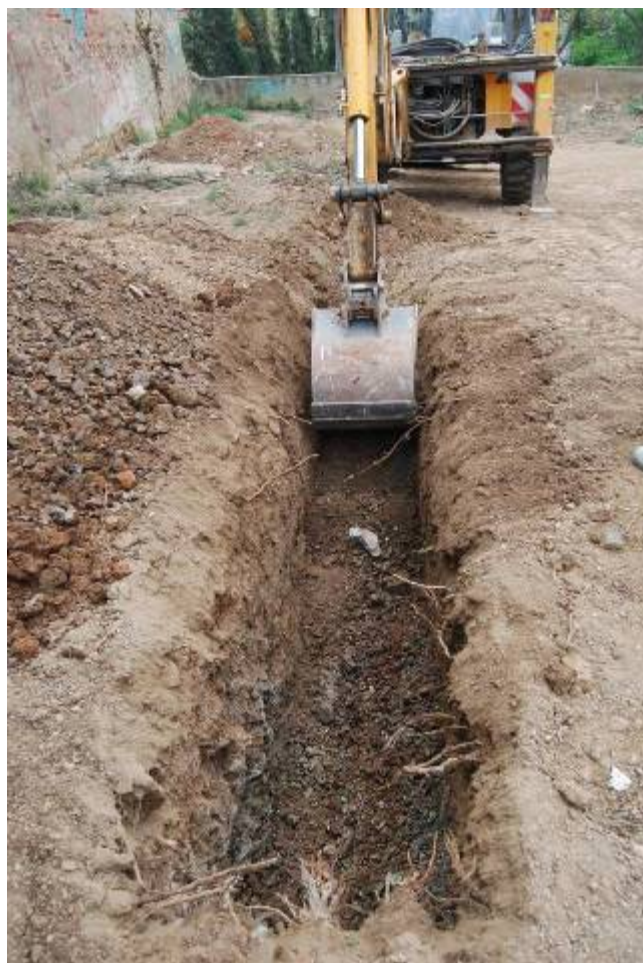
Fotografia núm. 12: obertura de la rasa 400
